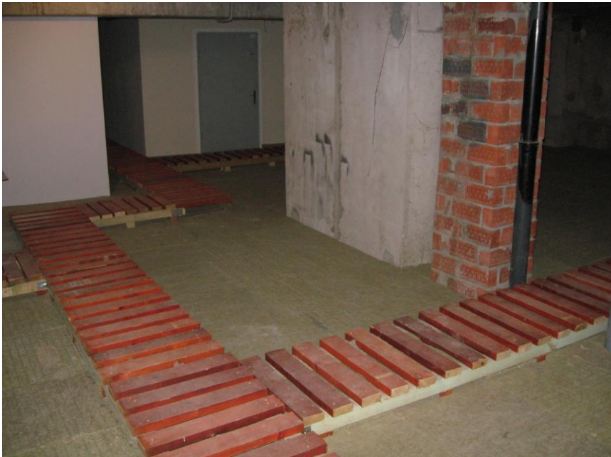
Bēniņu telpas grīda pēc siltināšanas
