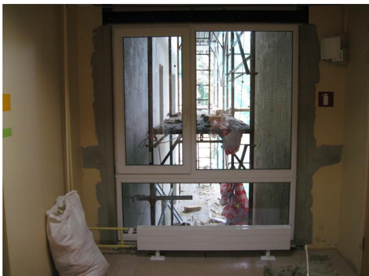
Jauno gaiteņa logu un radiatoru montāža
