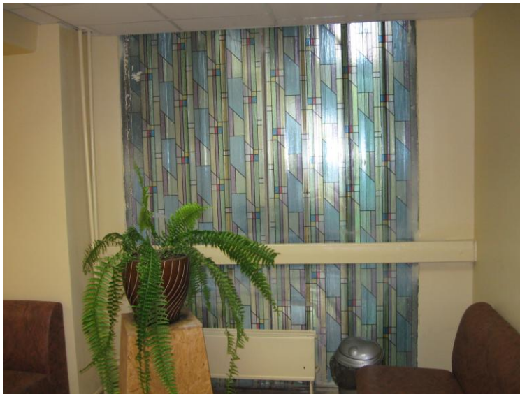
Gaiteņa logi un radiatori pirms demontāžas
