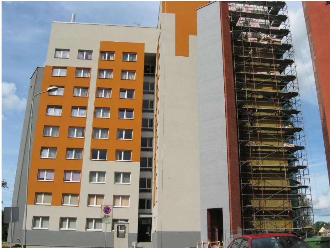
Ēkas fasādes siltināšanas darbi
