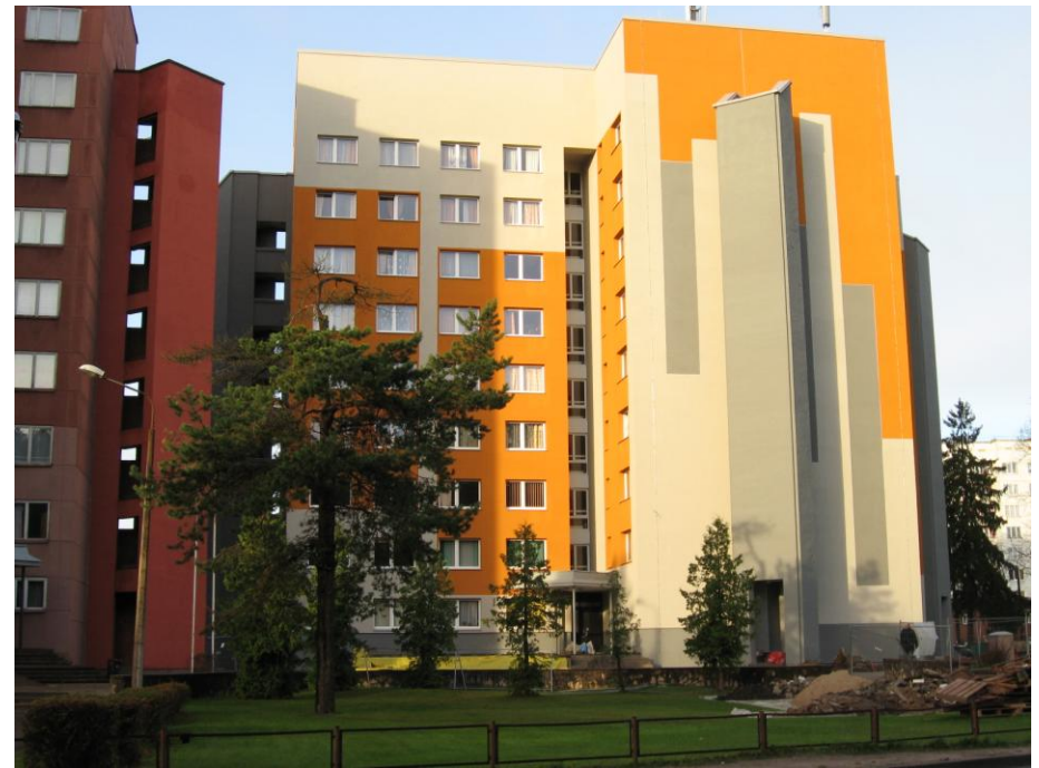
Objekts pēc darbu pabeigšanas, 2012.gada novembris
