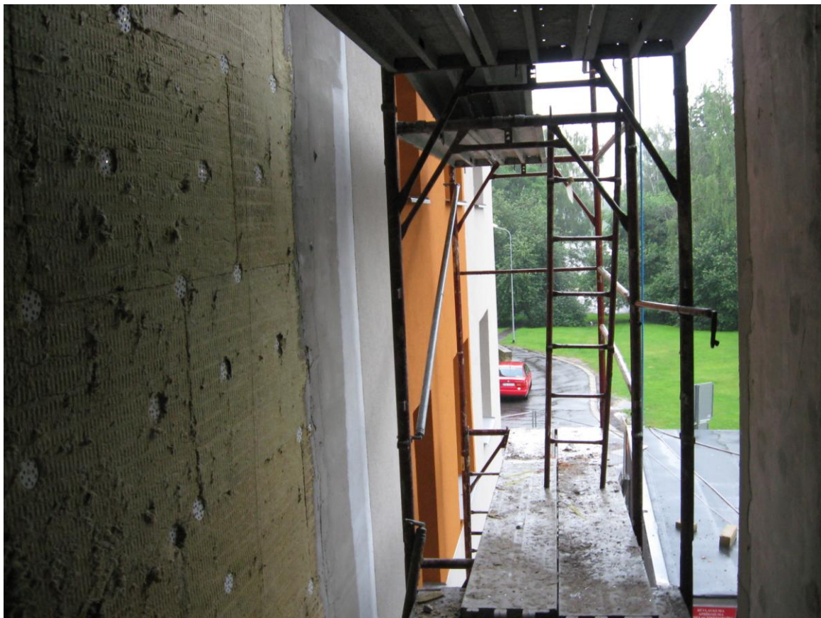
Fasādes siltināšana un apdare
